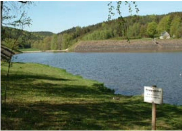
Stauraum und Absperrbauwerk der Talsperre Krebsbach
