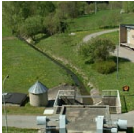
Blick vom Staudamm in den Unterlauf des Krebsbaches
