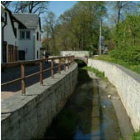
Stark verbauter Krebsbach in der Ortschaft Teichwolframsdorf
