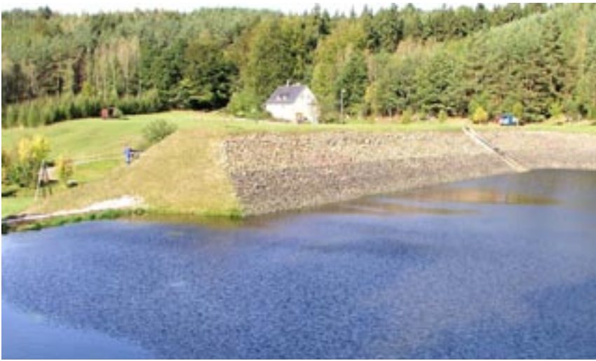
Wasserseite des Absperrbauwerkes
